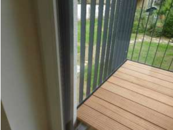
Beispiel Terrassenbelag Lärche und Flachstahlgeländer
